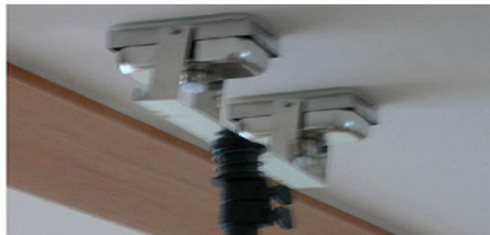
sposób instalacji próbników na powierzchni sufitu
