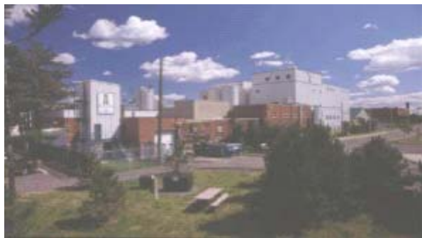
Widok ogólny fabryki
